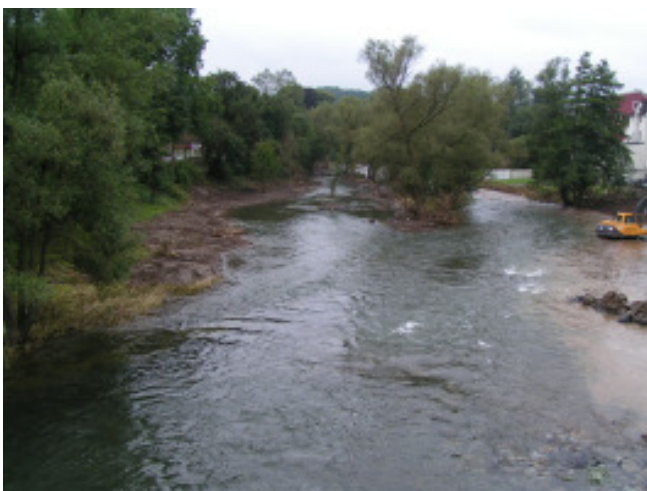
Bild 10: innerstädtische Aufweitung zur Verbesserung des Hochwasserschutzes
