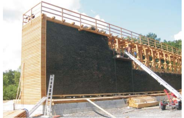
Seitenansicht in Richtung Park
