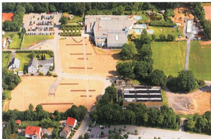
Eine riesige Erdfläche, aus der mittlerweile die ersten Grashalme sprießen, ist vor dem NASS angelegt worden. Mit Sträucherstreifen wird die neue „Große Wiese“ aufgelockert. Oben rechts ist bereits das Fundament für das Gradierwerk zu sehen. Luftbild: Fischer
