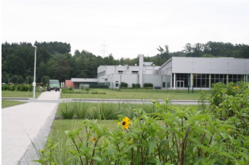
Wegeverbindung in Richtung NASS
