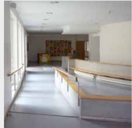
Die Rampe ist auf beiden Seiten mit Handläufen ausgestattet; eine halbhohe Brüstung dient hier auch als Sitzbank
