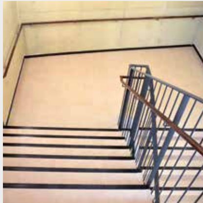
Ein um das Treppenpodest herumgeführter Handlauf bietet Orientierung und Sicherheit für Menschen mit Einschränkungen des Sehens oder der Motorik
