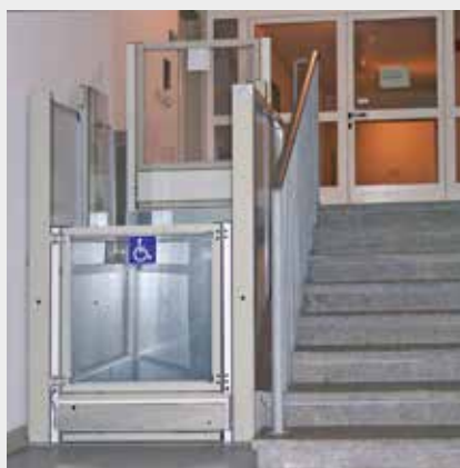
Rollstuhl-Hebebühnen sind geeignet für die Überwindung geringer Höhenunterschiede in Bestandsgebäuden
