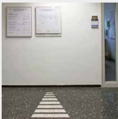
Die Bodenkennzeichnung weist auf Etageninformationen hin, die zusätzlich in Brailleschrift und erhabener Profilschrift ausgeführt sind
