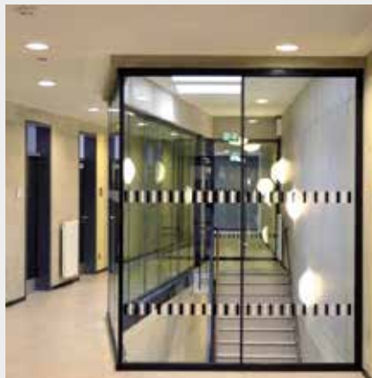
Die Glasfläche ist in Kniehöhe und Augenhöhe mit kontrastreichen Markierungen versehen
