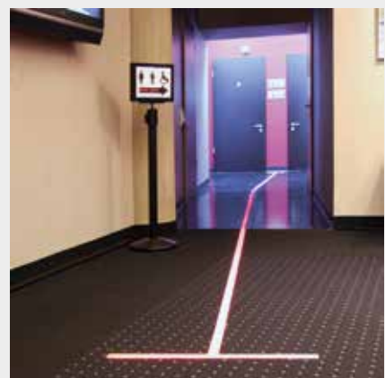
Eine taktiler Leitlinie aus Acrylglas, die mit Hilfe von Leuchtdioden von unten beleuchtet wird, führt zu den Toiletten
