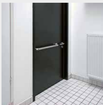
Die Zuziehstange erleichtert Personen im Rollstuhl das Öffnen und Schließen der Tür, der Türdrücker hält jedoch nicht die 50 cm Mindestabstand zur Wand ein
