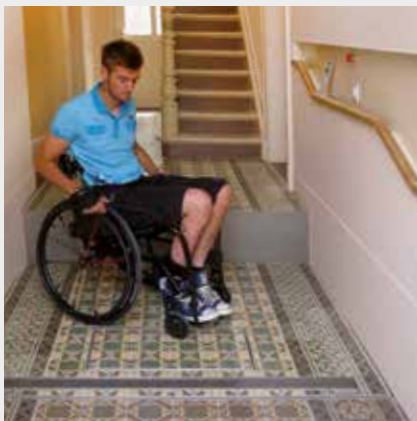
Die Hebebühne überwindet zwei Treppenstufen, in Ruheposition dient sie als mittlere Treppenstufe
