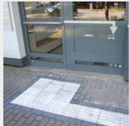
Ein Noppenfeld weist auf die Eingangstür und die rechts angeordnete Klingel hin
