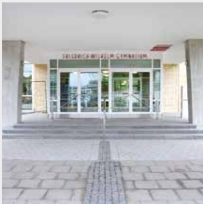
Ein taktiler Auffindestreifen aus Kleinpflaster weist auf den Eingang einer Schule hin
