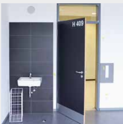
Tür, Raumnummer, Lichtschalter und Waschbecken heben sich kontrastreich von der Umgebung ab
