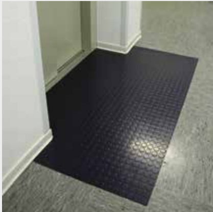
Ein Belagswechsel in Form eines taktil und visuell kontrastierenden Noppenfeldes erleichtert blinden Menschen das Auffinden des Aufzugs
