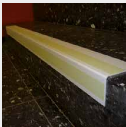
Die Stufenvorderkante mit Reflektor wurde nachträglich auf eine Kunststeintreppe aufgeklebt
