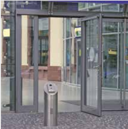
Die kraftbetätigte Tür lässt sich sensor-gesteuert öffnen; der Türöffner befindet sich in ausreichendem Abstand zur Tür
