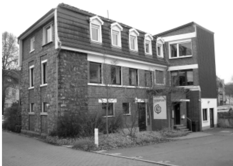
Gebäude Wendepunkt Lange Wende 16 a, Arnsberg-Neheim
