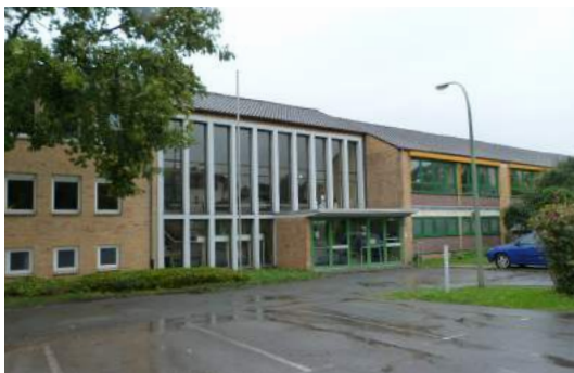
ABB 064 Kommunale Gebäude in Hüsten Quelle: SSR
