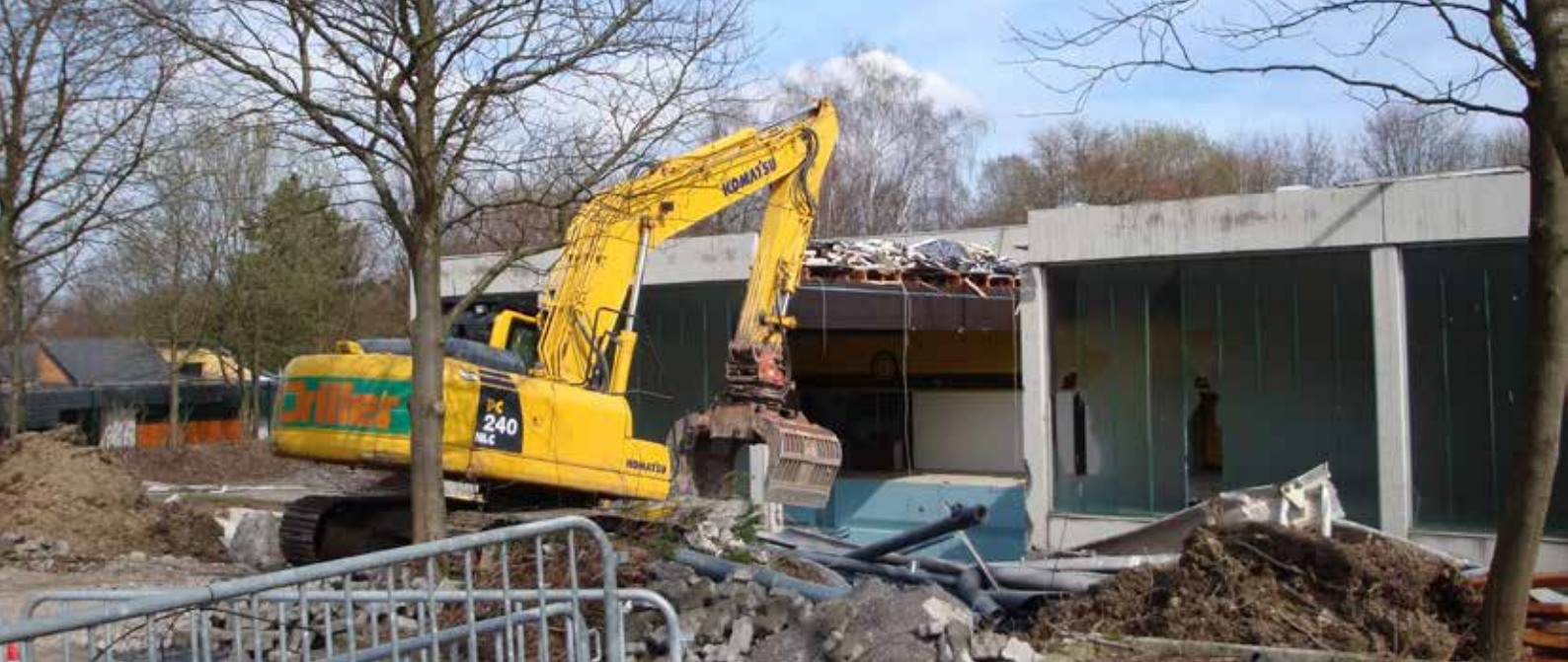
Abbruch ehemaliges Lehrschwimmbecken
